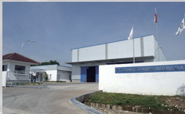
PT.SANKI CRANES INDONESIA 社屋(ジャカルタ)
