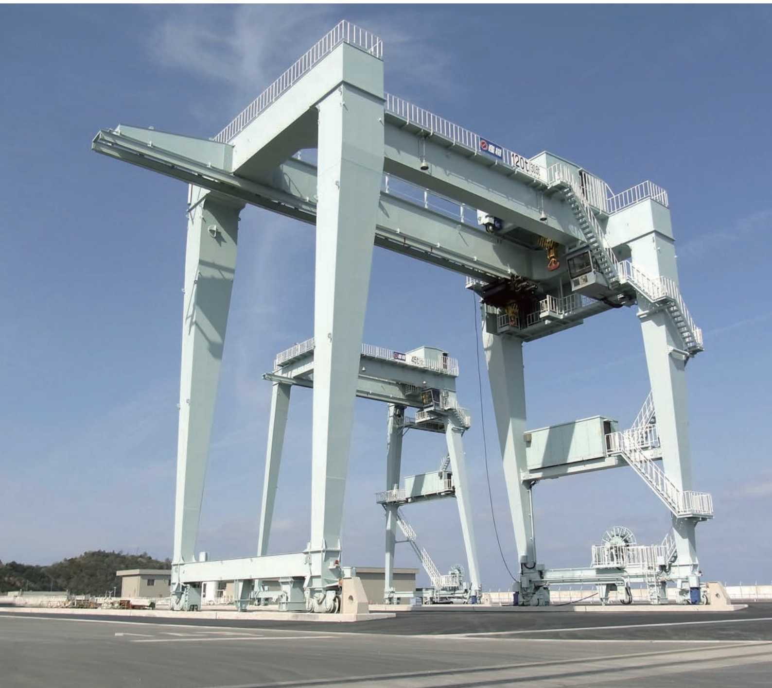
屋外搬送用 120/30.5t×23m 橋型クレーン 45/10t×17.5m 橋型クレーン
