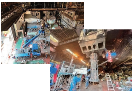
マスト部解体作業 (老朽化更新案件)
