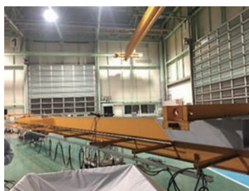
クレーン移設・改造 (桁の長さ延長)
